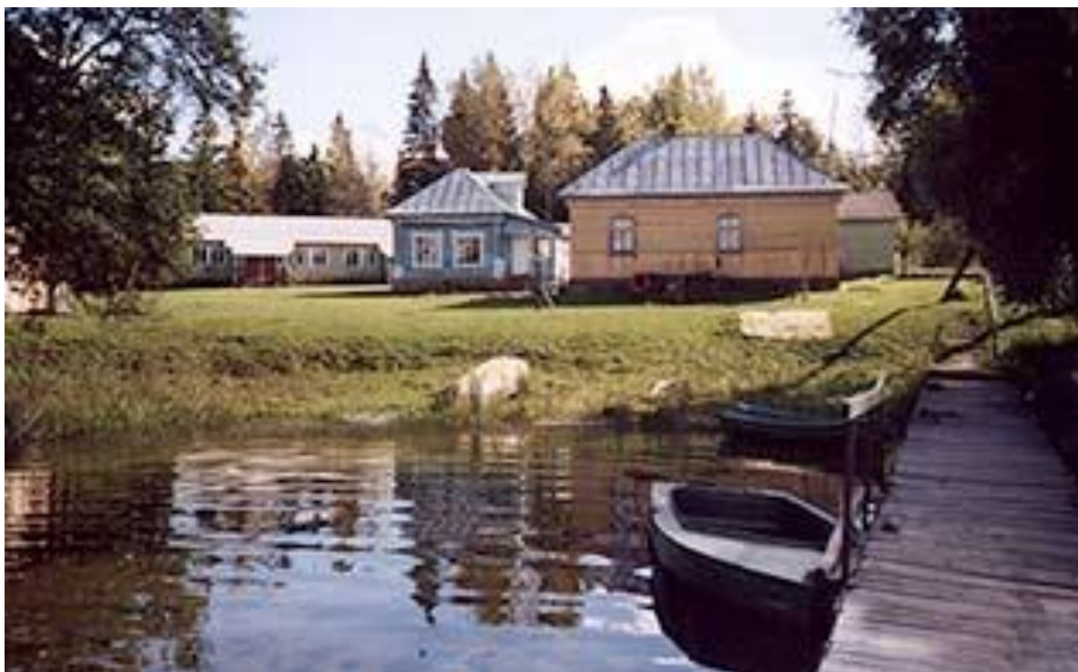
Общий вид нового здания биостанции со стороны озера Глубокое
