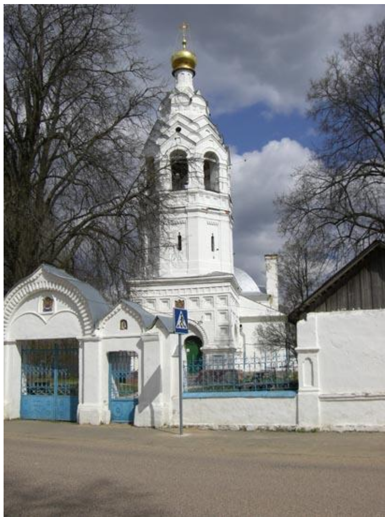
Общий вид Покровской церкви
