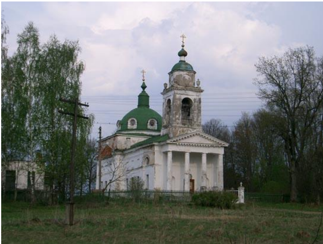
Общий вид Покровской церкви
