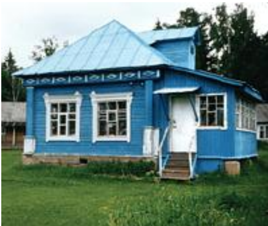
Общий вид старого здания биостанции
