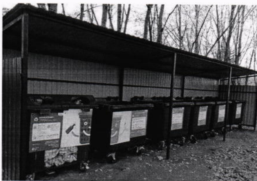
Рис. 4.13. Вариант обустройства контейнерной площадки
